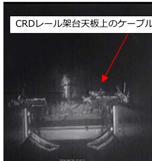
【高圧水洗浄完了時のCRDレール天板上の状態】
