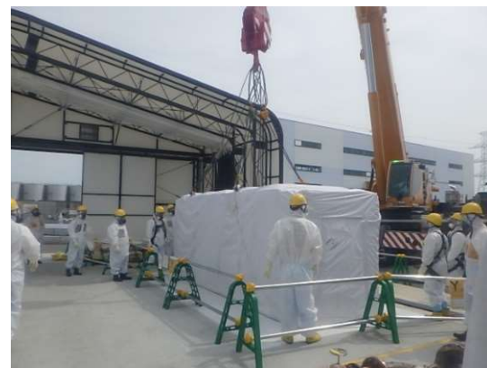
ジャバラテントへの移送・設置
