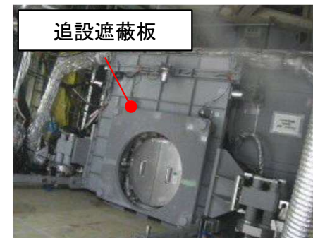
追設遮蔽板装置設置
