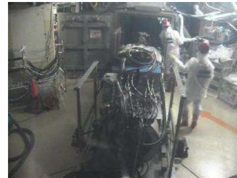
【2号機R/B建屋内】
