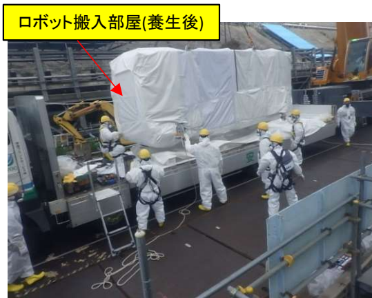
養生後トラック積込み
