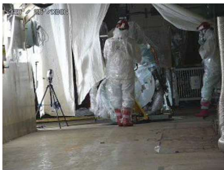
延長管装置運搬
