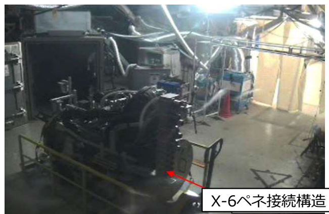
2号機内運搬状況
